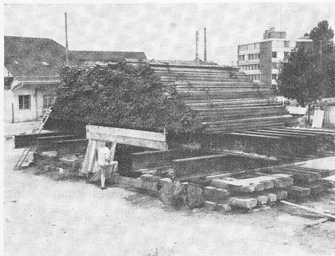
Bild 1. Einrichtung für den Belastungsversuch am 19 m tiefen Schlitzwandelement
