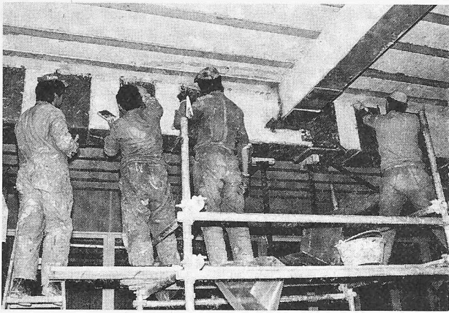
Bild 30. Montage der Schubbleche an den Hauptunterzügen
