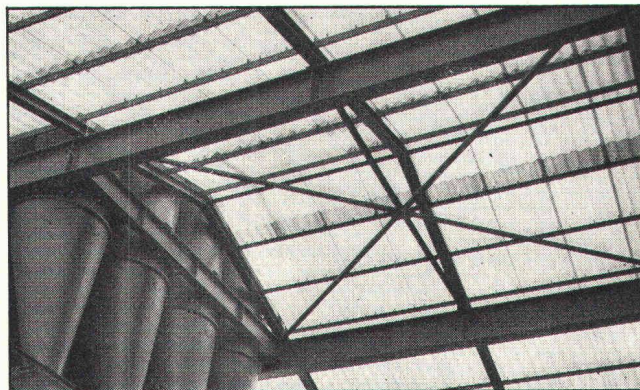
Neomat-Lichtdach auf einer Siloanlage
