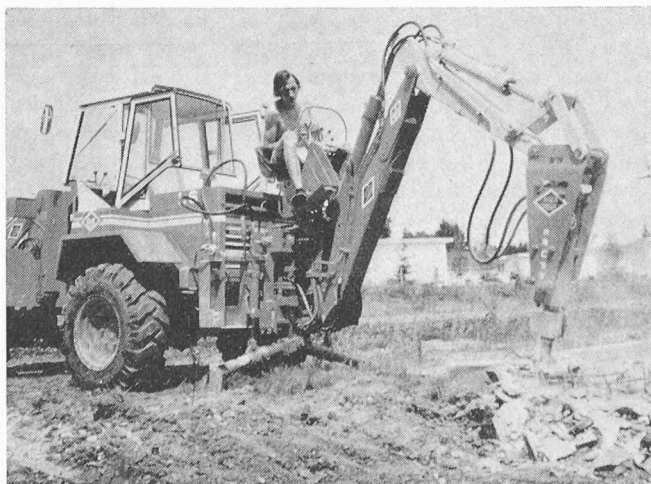
Bild 1. HM100 am Hecktieflöffel eines Kleinladlers beim Abbau von armiertem Beton
