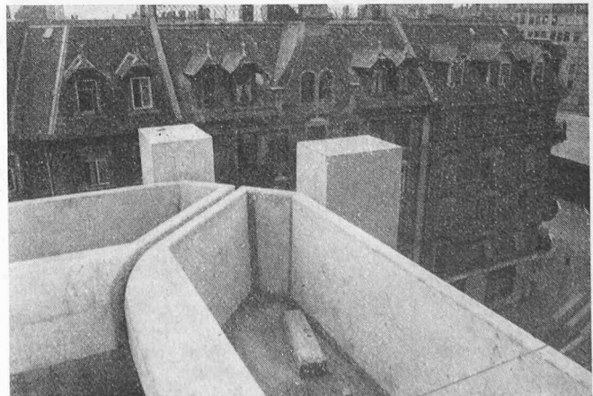
Eckausbildung der Brüstungströge auf der Dachterrasse
