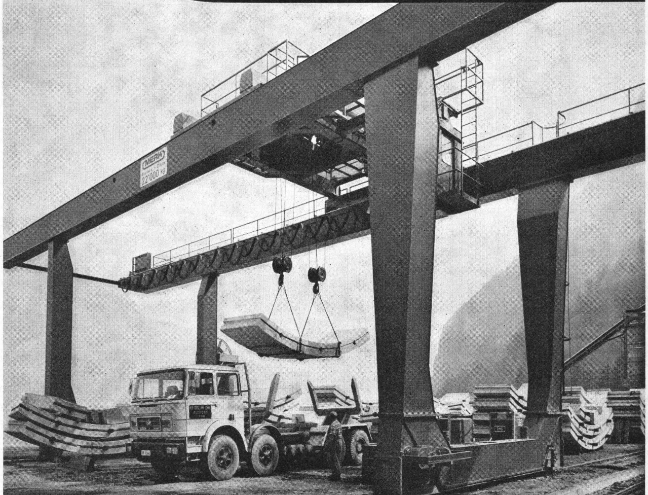
22-t-Kran in Bauen (Vierwaldstättersee) für den Umschlag von Auskleidungselementen eines Autobahntunnels.
