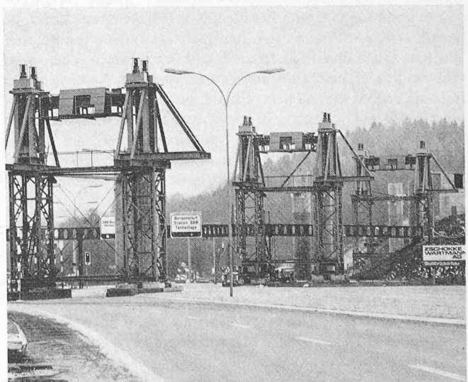
Bild 7. Die Montagehilfskonstruktion vor dem Einschieben
