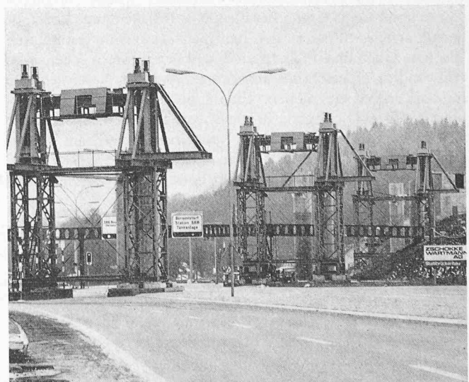
Bild 7. Die Montagehilfskonstruktion vor dem Einschieben
