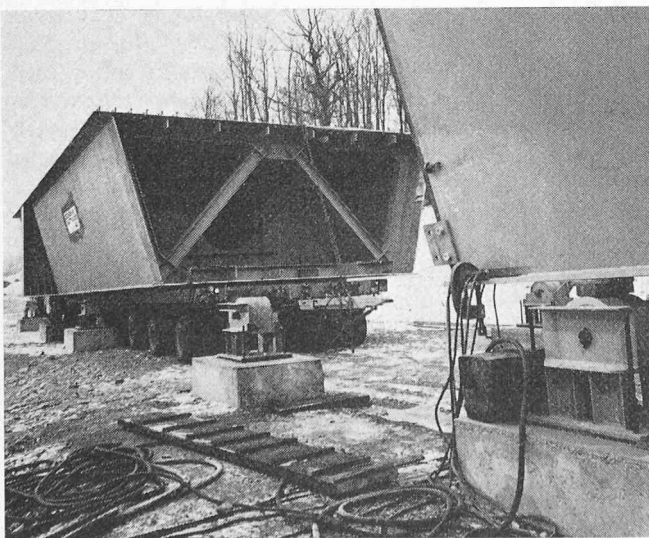
Bild 6. Transport zur Baustelle und Einfahren der einzelnen Trägerschüsse auf die Rollenlager
