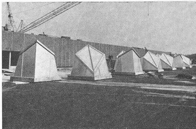
Dachoblichter über der Mall. Durch ihre Anordnung wird das Licht von verschiedenen Richtungen eingefangen
