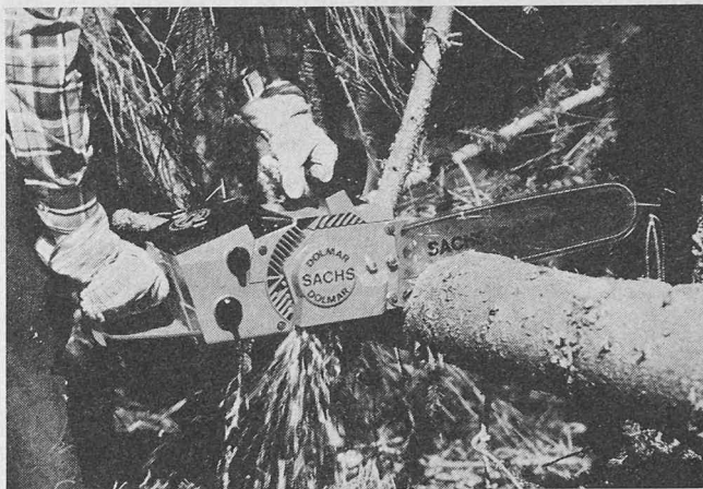
Die erste Wankelsäge der Welt im Einsatz
