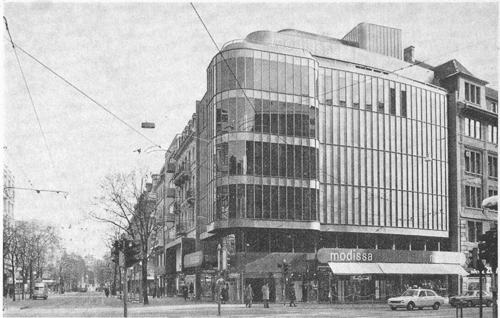
Das im Neuzustand noch goldglänzende Metallhaus «Modissa» an der Ecke Bahnhofstrasse-Uraniastrasse Photos: Urs Rüfenacht, Zürich
