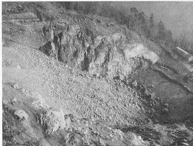
Bild 6. Bergsturzablagerung im Steinbruch Köppl nach dem Hauptsturz, Zustand 24. Januar 1974
