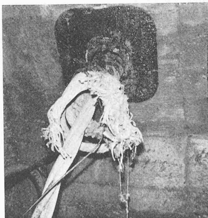
Bild 2. Zerrissenes Seil nach dem Entfernen der Presse
