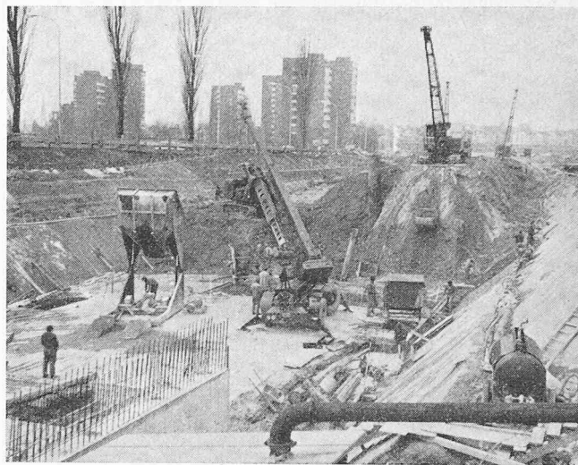
Bild 8. Blick von der Hilfsbrücke gegen W
