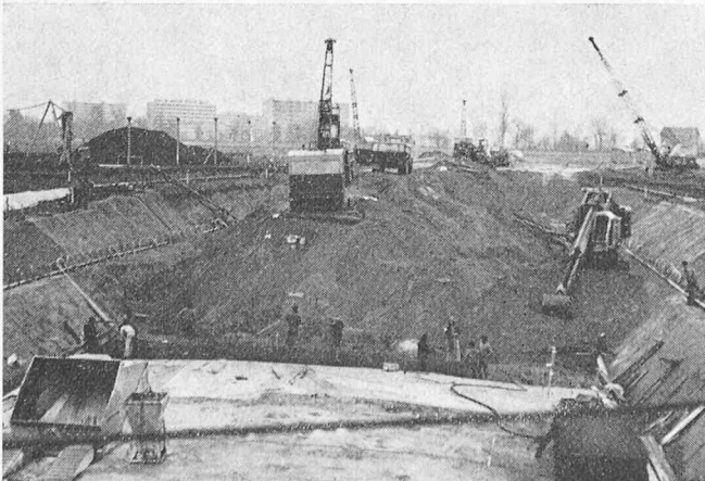
Bild 7. Blick von der Hilfsbrücke gegen E
