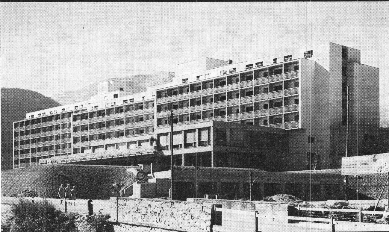
Hotel ACLA DE FUNTAUNA IN DISENTIS. Architekturbüro Mathis in Chur. Spenglerei Candidas in Rabiuis. Sämtliche Flachdacheinfassungen und Wandanschlüsse aus RHEINZINK.
