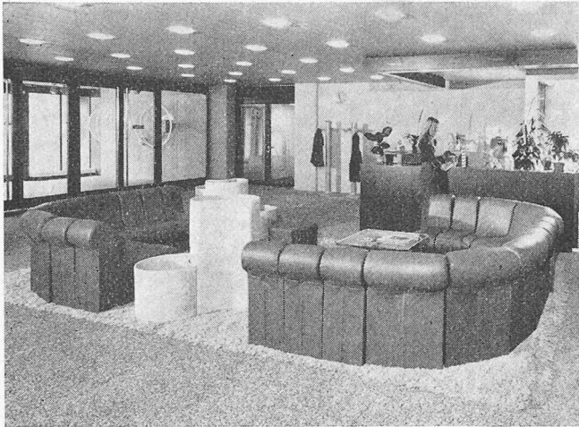
Haupteingang und Loge, Gebäude C
