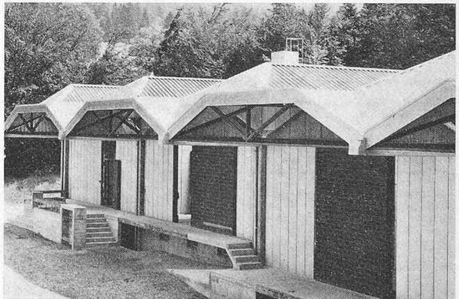
Halle 2: Eingangsseite (Nordfassade)
