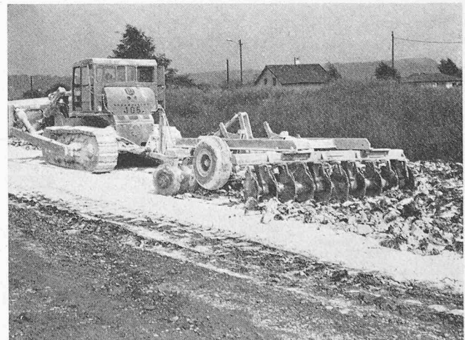
Bild 6. Eine Caterpillar-Ladeschaufel mit gezogener Rome-Scheibenegge TRW 20-30 vermischt Boden und Stabilisierungsmittel. Arbeitsbreite 3,35 m
