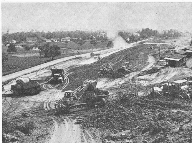
Bild 1. Bodenstabilisierung mit Kalk auf der Baustelle N3/02 Wallbach-Möhlin im Kanton Aargau
