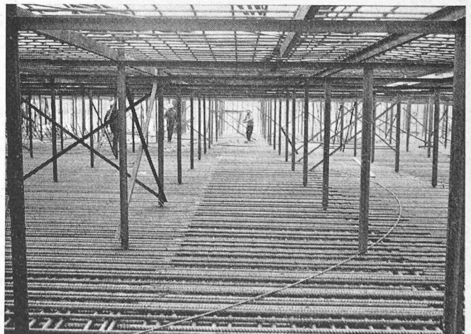
Bild 7. Fundamentplatte des Reaktorgebäudes. Abstützkonstruktion für die obere Armierung
