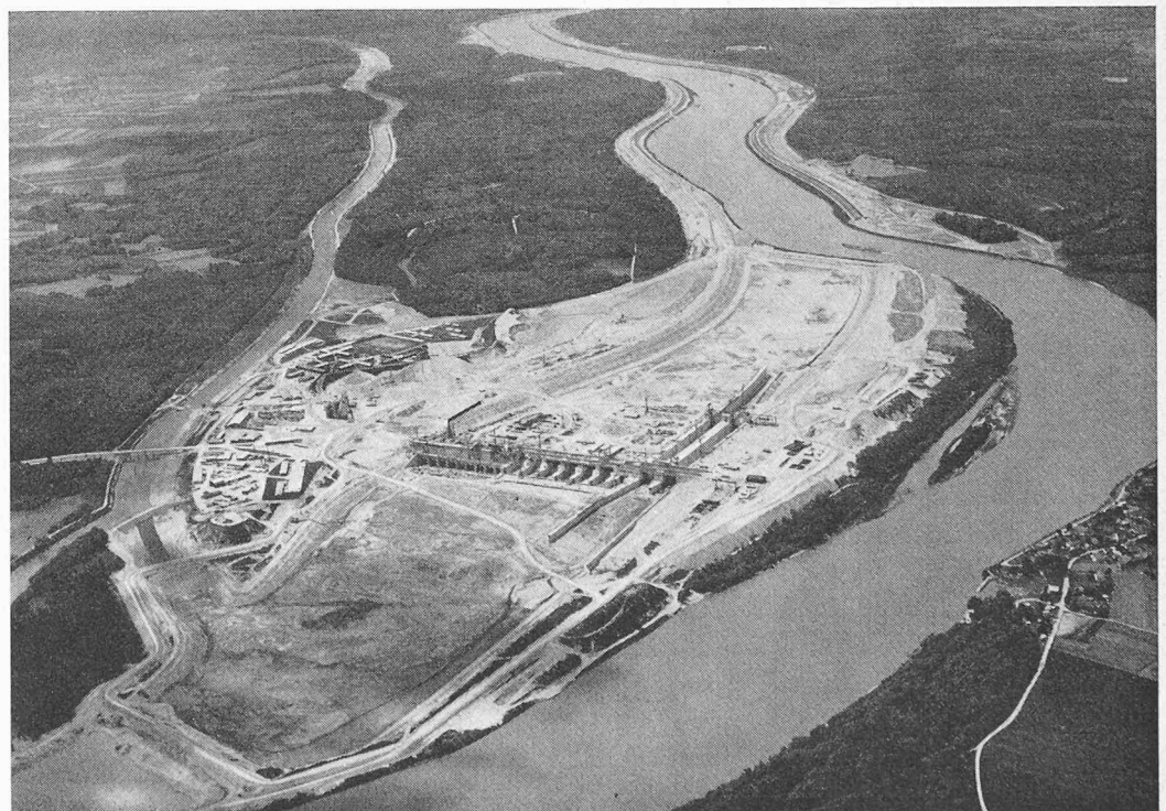
Bild 14. Gesamtansicht der Baustelle Altenwörth
