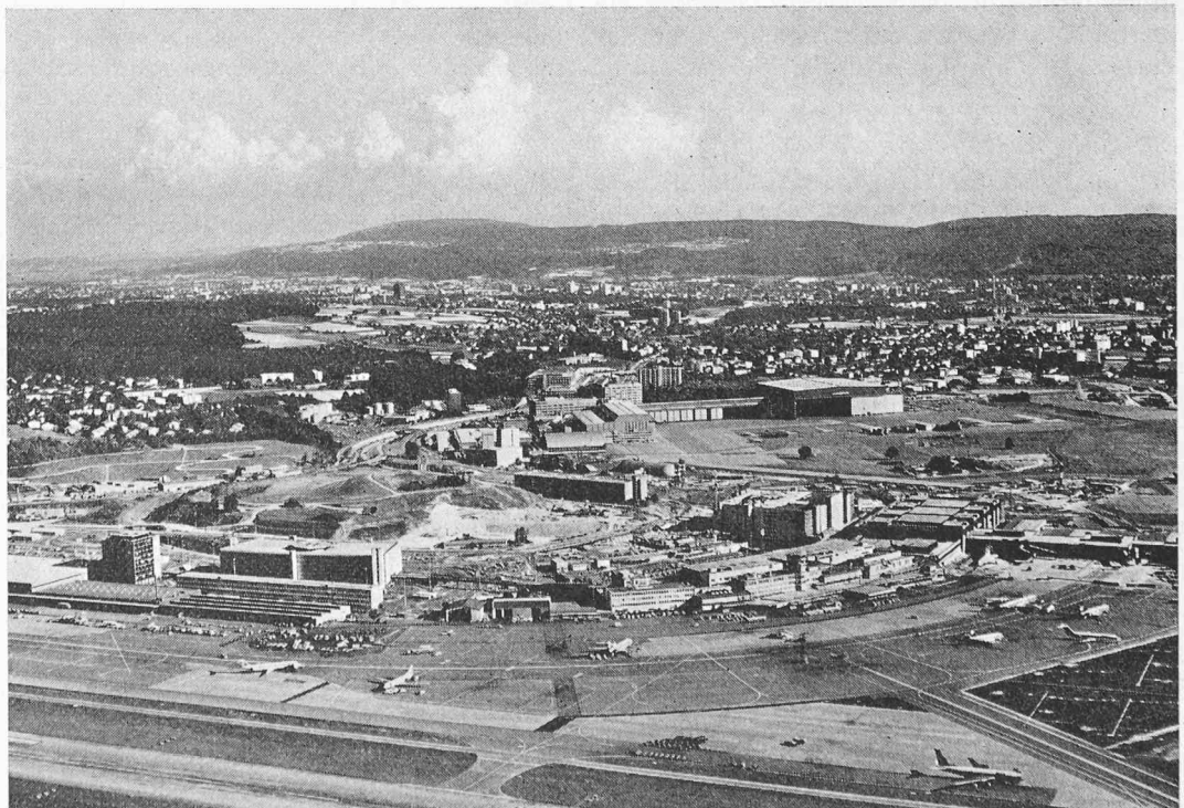
Bild 7. Ansicht des Flughafenkopfes von Norden aus. In der Bildmitte die Baustelle der SBB-Flughafenlinie. Im Hintergrund das Werftareal (Flugaufnahmen Comet Photo AG )
