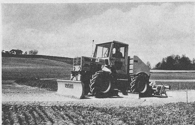
Die MBB 5 = 1 mit Grobplanierschild, Feinplanierschild und Plattenverdichter beim Bau einer Gemeindestrasse
