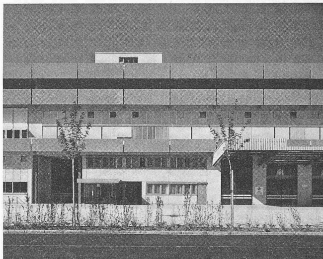
Teilsicht der Südfront. Im Erdgeschoss Haupteingang, Portier, Sanität und Tor zur Warenannahme. Im Zwischengeschoss liegen Konferenzräume, im Obergeschoss Büroräume und die Kantine. Hinter den zwei obersten Brüstungsbändern befinden sich die Parkebenen
