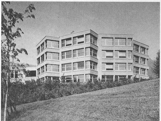
Klassentrakt, Ansicht von Südosten
