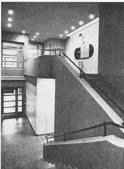
Treppenhaus im Turnhallentrakt
