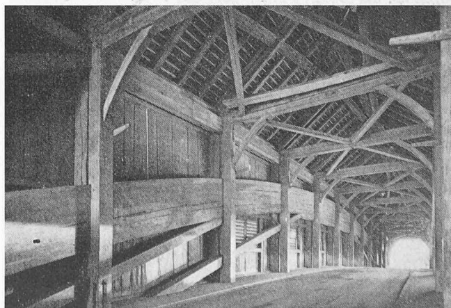
Hasle-Rüegsau BE . Brücke über die Emme. Sprengwerk mit verzahnten Bogenträgern (Vorläufer der Hetzerträger?)
