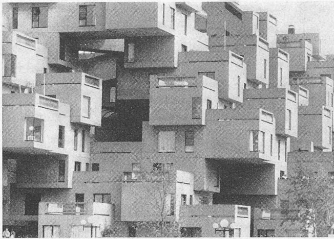
Bild 5. Ausschnitt aus dem Terrassenblock «Habitat 67», gebaut für die Expo 67 in Montreal durch den Architekten Moshe Safdie. Extreme Formulierung der Wohnraumbeschaffung mit Methoden der Industrialisationen
