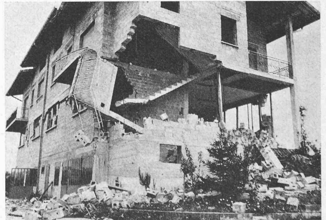
Bild 11 (nach dem 15. Sept.). Rechts: Wohnhaus mit Werkstatt bei Artegna nach erneuter Bebenbeanspruchung. Infolge der weiteren Bebenbelastung stürzte die Stirnwand im Mittelgeschoss ein. Die Tür- und Fensterepfosten der Längswände wurden zermalmt und brachen teilweise ein. Die Schubfestigkeit dieser Betonhohlsteinwände war gering, da der Mörtel in den Lagerfugen keine Verzahnung der übereinanderliegenden Schichten bewirkte
