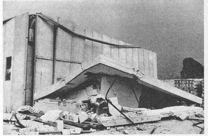
Bild 8 (nach dem 6. Mai). Links: Vorfabrizierte Halle mit Backsteinanbau in Gemona. Das Tragskelett der Halle ist unbeschädigt, dagegen wurden die Betonelemente der Seitenwand beim Aufprall an den steifen Anbau leicht eingedrückt. Die Kunststoffmasse der Wandfugen wurde infolge der grossen Verformungen zerrissen. Das Dach des Anbaues ist durch die Impulsbelastung des Anpralls infolge ungenügenden Bauwerkabstandes auf Fensterhöhe abgesichert und weggeschoben worden
