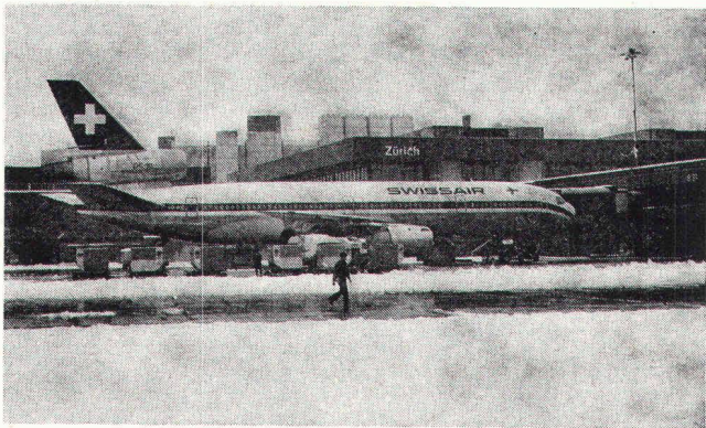
Im Flughafen Kloten werden 16 000 m 2 Standplätze mit einer MULTIBETON-Bodenheizung schnee- und eisfrei gehalten.
