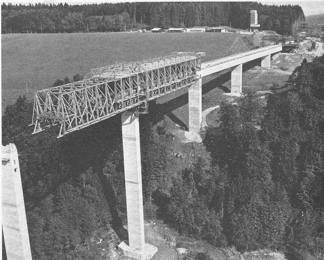
Bild 14. Übersicht über die Baustelle. Im Hintergrund sieht man das «Flügelgerüst» für die Verbreiterung der Brücke
