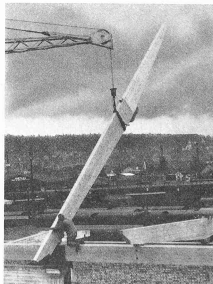
Bild 1 (links). Gerader Träger als Zwillingsträger ausgebildet, Länge 40 m, über 6 Felder durchlaufend, Bahntransport. Hersteller: W. Zöllig AG, Arbon
