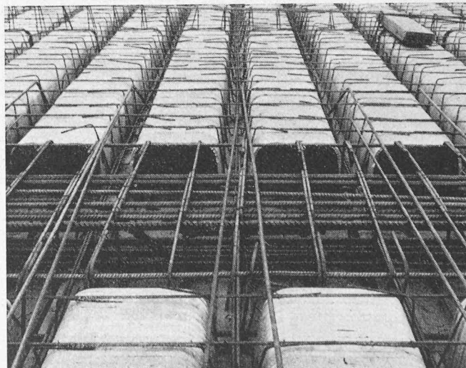
Bilder 7 und 8 unten. Verlorene Schalung in Stahlblechausführung
