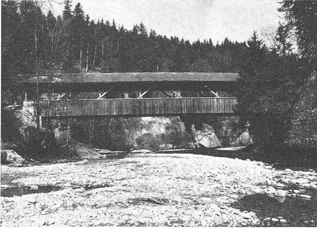
Ruchmühlbrücke vor der Zerstörung
