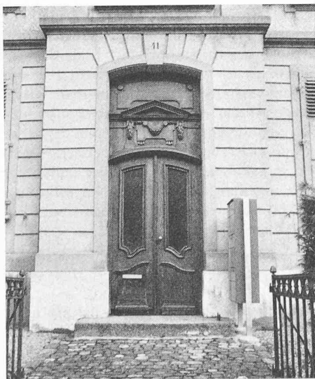
Links: Das Eingangsportal – eine handwerklich ausgezeichnete Arbeit, die heute noch vollständig intakt ist
