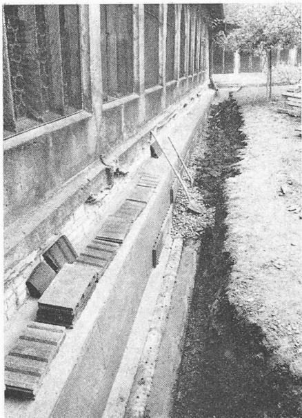
Links: Sanierung der Kreuzgangfundamente; rechts: Kirche Seitenschiff, Nordfassade, Freilegung der frühgotischen Spitzbogen
