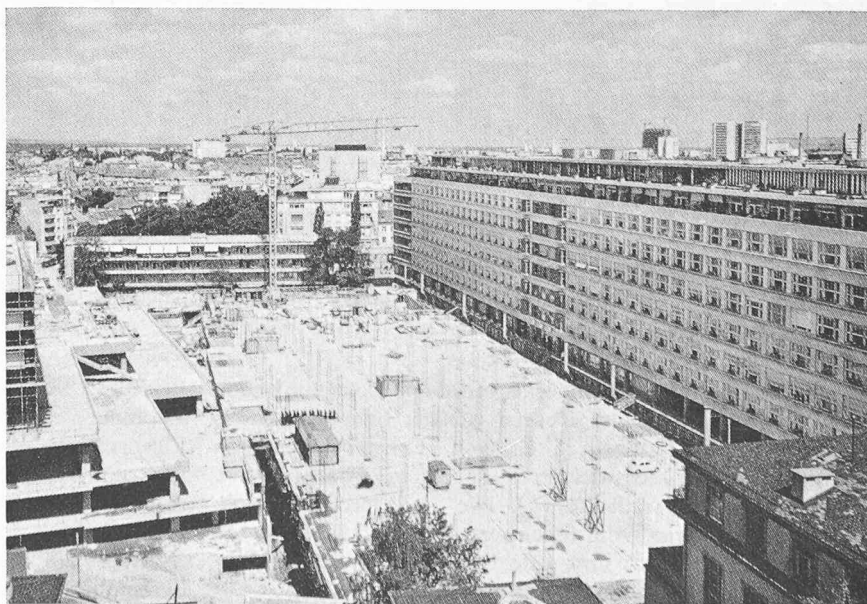
Bild 1. Vogelschau der Baustelle. Die grossflächige, fünfstöckige Tiefgarage liegt unmittelbar neben dem bestehenden Spitalgebäude. Die über die oberste Decke herausragenden vertikalen Spannstrangen dienen zum Absenken der darunterliegenden Decken
