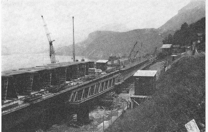
Bild 7. Vorschubgerüst nach der ersten Vorfahrt. Hinten im Bereich des betonierten Brückenfeldes der rückwärtige Fachwerkschnabel. Dann folgt der kastenförmige Rüstträger, der an der Koppelfuge aufgehängt ist. Vorne ist der 46 m Vorfahrschnabel mit Auflagerung auf der Quertraverse beim Pfeiler 4. Auf dem betonierten Teil sind 5 m lange Elemente der klappbaren Innenschalung zu sehen (Aufnahme: D. J. Bänziger, 21. 7. 1977)
