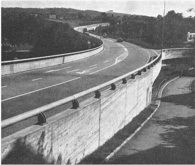
Bild 1. Gesamtansicht von Norden
