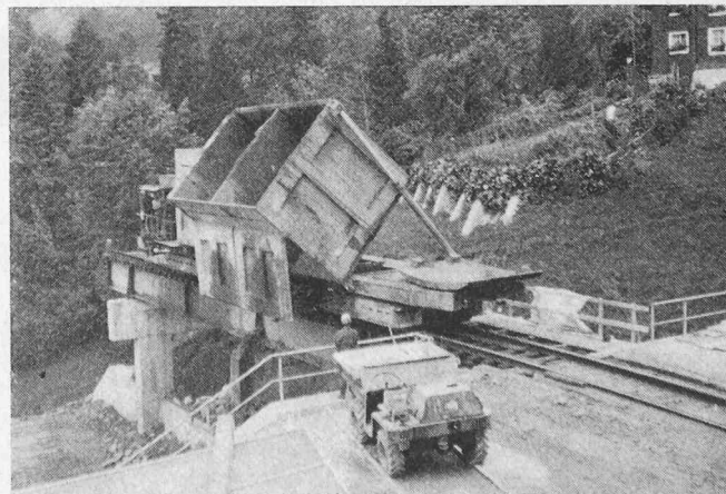
Bild 20. Der «Mine-Car» kippt das Felsausbruchmaterial auf die Zwischendeponie
