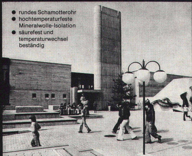
Schulhaus Lindenbühl Volketswil, Arch. Alfred Frei, Arch. SIA, Wetzikon
