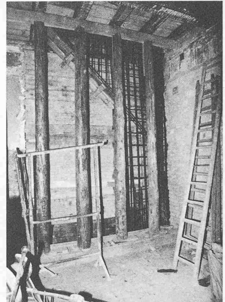
Bild 3 (links) Gussstütze im Erdgeschoss mit Stahl-Holz-Verbundträger als Unterzüge
