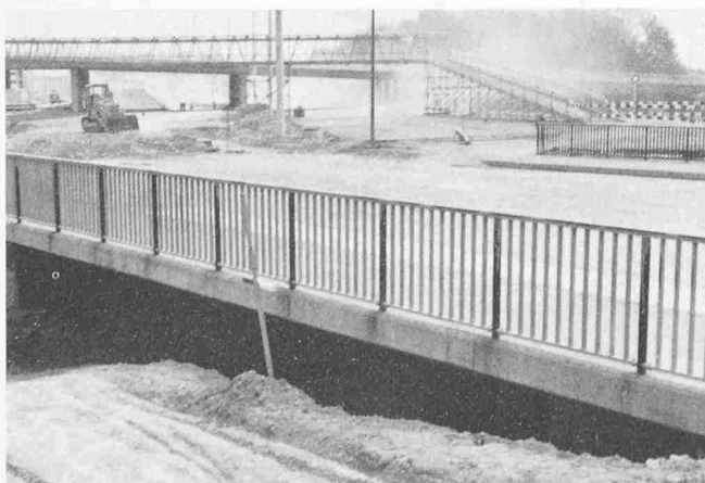
Bild 1. Blick von der Nordseite der Brücke im Vordergrund in Richtung Osten View from the north of the bridge in the foreground, running eastwards
