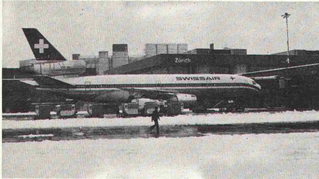
Im Flughafen Kloten werden 16 000 m 2 Standplätze mit einer MULTIBETON-Bodenheizung schnee- und eisfrei gehalten.
