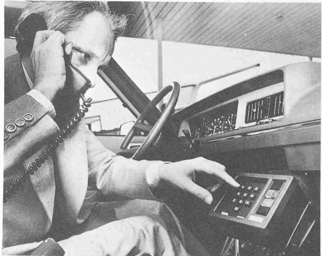
Natel-Mobilstation, eingebaut in Fahrzeug
