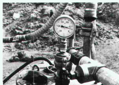
Wasserhaltung mit Vakuumbrunnen
