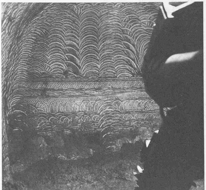
Bild 23. Gefräste Vortriebsbrust im Molassefels des Entlastungsstollens
