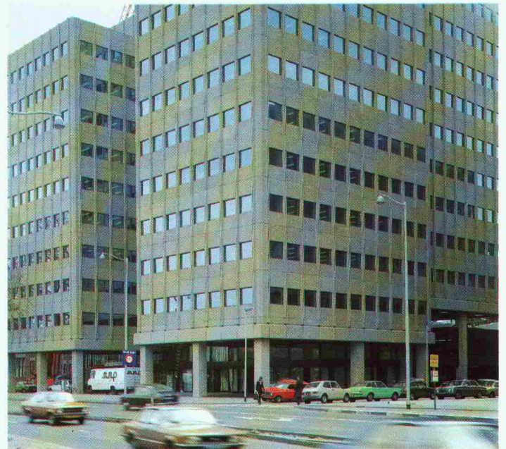
Kantoorgebouw Ass. Mij Nieuw Rotterdam, NL-Rotterdam, 1977 INFRASTOP-Auresin 39/28 + PHONSTOP Elffers Partners BV Architectenburo, Rotterdam
