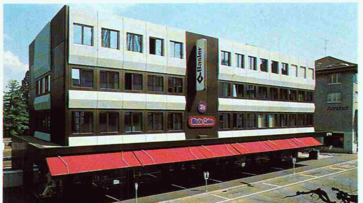
Geschäftshaus, CH-Thalwil, 1976 INFRASTOP-Auresin 39/28 Arch. G. Theiler, Thalwil
