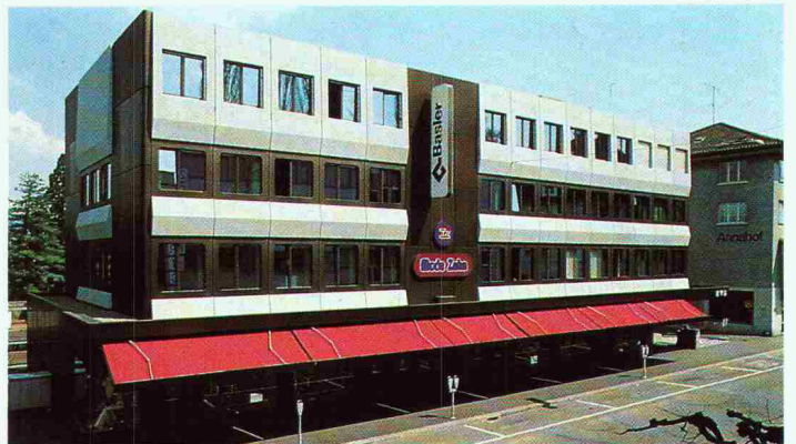
Geschäftshaus, CH-Thalwil, 1976 INFRASTOP-Auresin 39/28 Arch. G. Theiler, Thalwil
