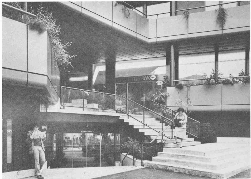
Zugänge auf der Westseite (Seestrasse), rechts Aufgang zum ersten Obergeschoss, links Abgang zur Ladenstrasse
