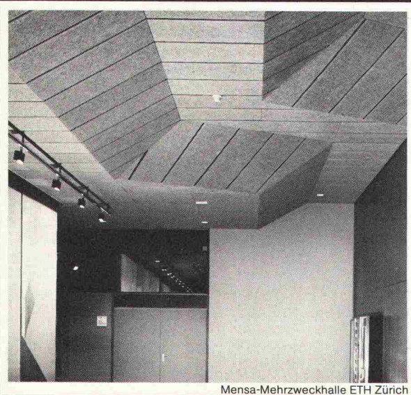
Mensa-Mehrzweckhalle ETH Zürich
