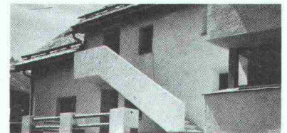
Beispiel einer gelungenen Sanierung eines Altbaues mit Renesco-Thermocrete-Wärmedämmputz (1800 m 2 ü. M.)
