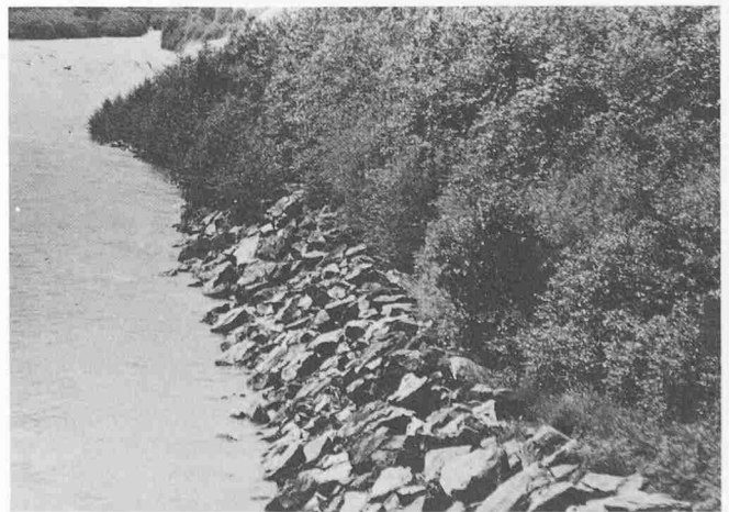
Bild 13 (unten). Blockwurf zur Ufersicherung, hier richtig flach geschüttet. Vorne nicht bepflanzt, hinten bepflanzt. 9 Jahre alt
