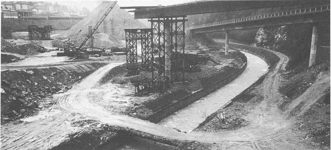
Bild 1. Kanalisierter Flussabschnitt im Raume von Airolo
