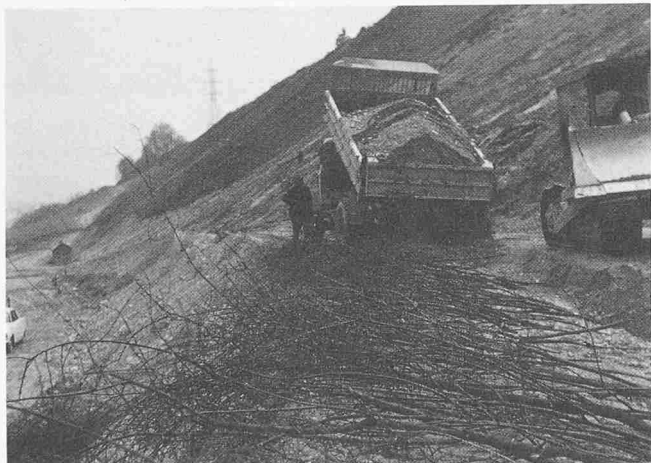
Bild 5. Buschlagenbau während der Schüttung
